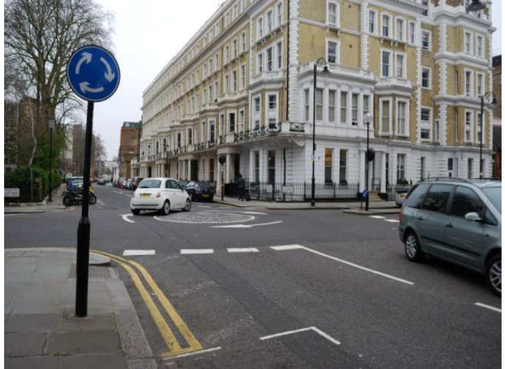
トラフィック・サークル(非幹線道路では、信号機の代わりに交差点内中央を円形に盛り上げ、単路部からの速度を維持できないように速度を抑制させている。
