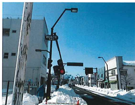
(大雪による信号機倒壊のようす)
