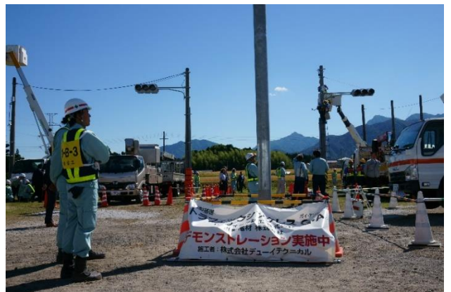
鋼製基礎による短時間建柱工事のデモンストレーション
