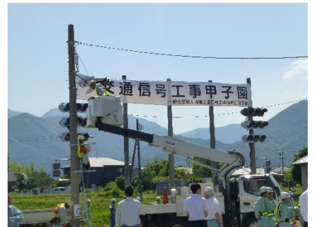
灯器取替工事競技
