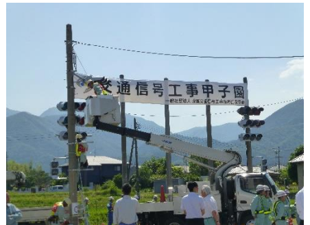
灯器取替工事競技
