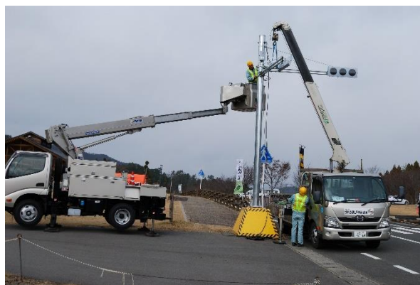
仮設信号機の設置作業
