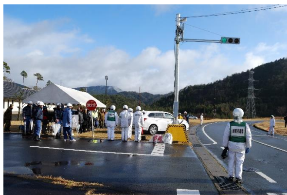
仮設信号機の点灯訓練
