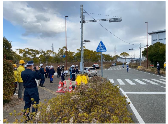
仮設信号機の設置状況
