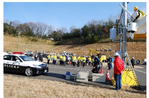
仮設信号機設置状況
